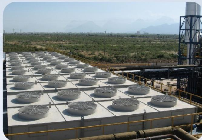
Enerji Tesisi'nde Kullanılan Kuru Soğutucu Radyatör Uygulaması
