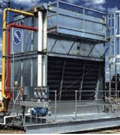
Şekil 2.25 Evaporatif kondenser ve elemanları
